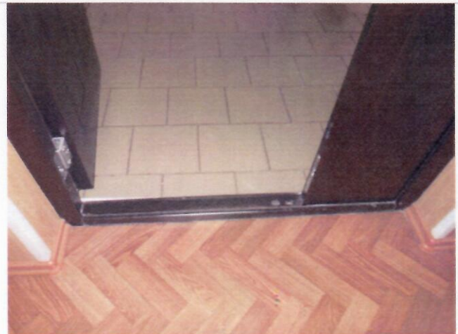
Фото №24 – Пути движения внутри здания (двери)
