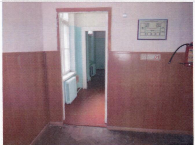
Фото №22 – Пути движения внутри здания (двери)
