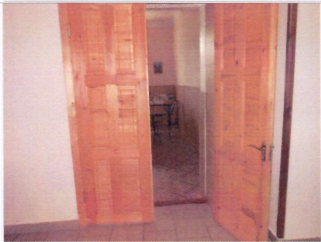
Фото №21– Пути движения внутри здания (двери)
