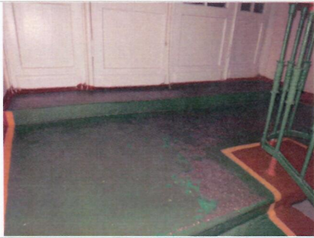
Фото №19 – Пути движения внутри здания (лестницы, двери)
