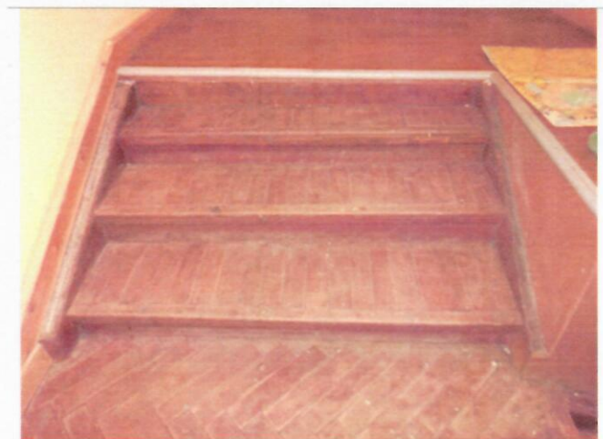
Фото №17 – Пути движения внутри здания (лестницы)
