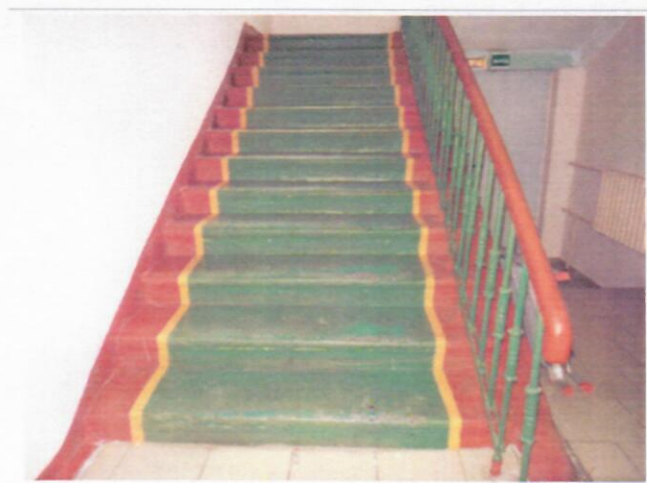
Фото №18 – Пути движения внутри здания (лестницы)
