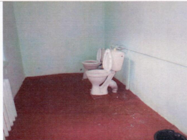
Фото №35 – Санитарно-гигиеническое помещение
