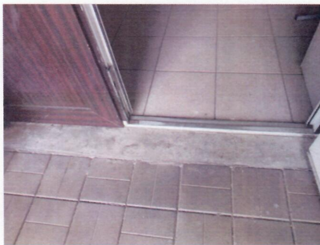
Фото №10 – Наружная входная дверь
