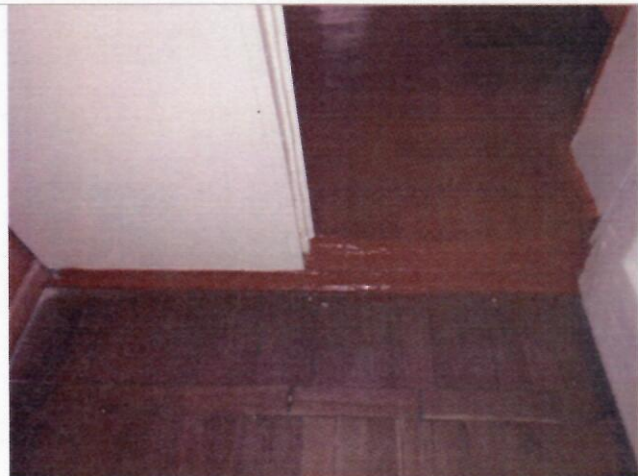
Фото №23 – Пути движения внутри здания (двери)
