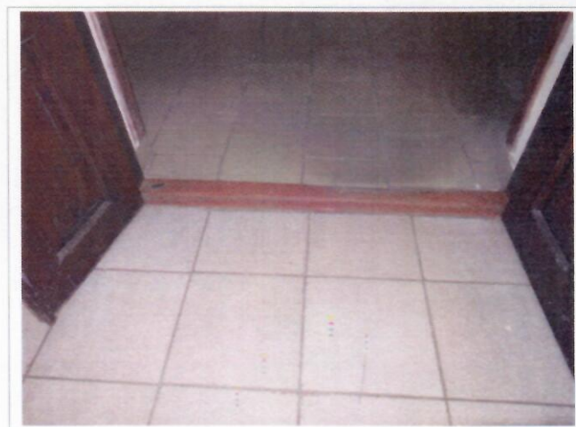
Фото №12 – Внутренняя входная дверь
