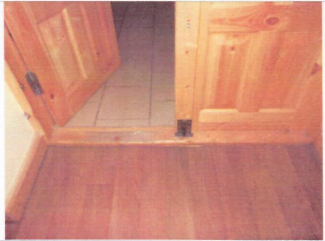
Фото №20 - Пути движения внутри здания (двери)
