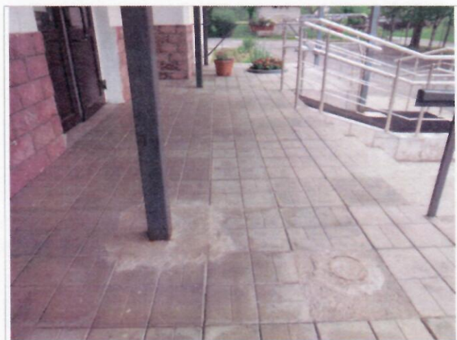
Фото №9 – Входная площадка главного входа
